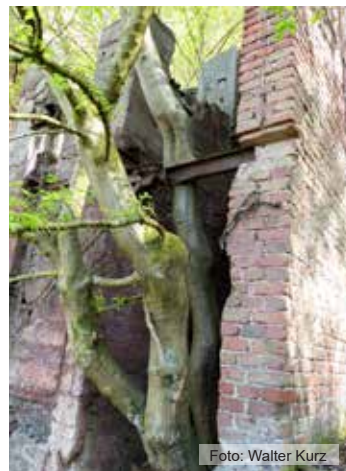
Ruine der Verladestelle der Grube Buchwald am 21.04.2015
